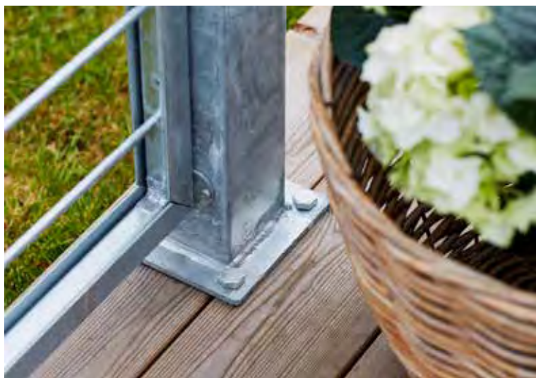
Stahlpfosten mit Fuss - Detail
